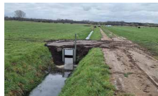
Fig. 6 Baraj instalat pe un câmp. 37
