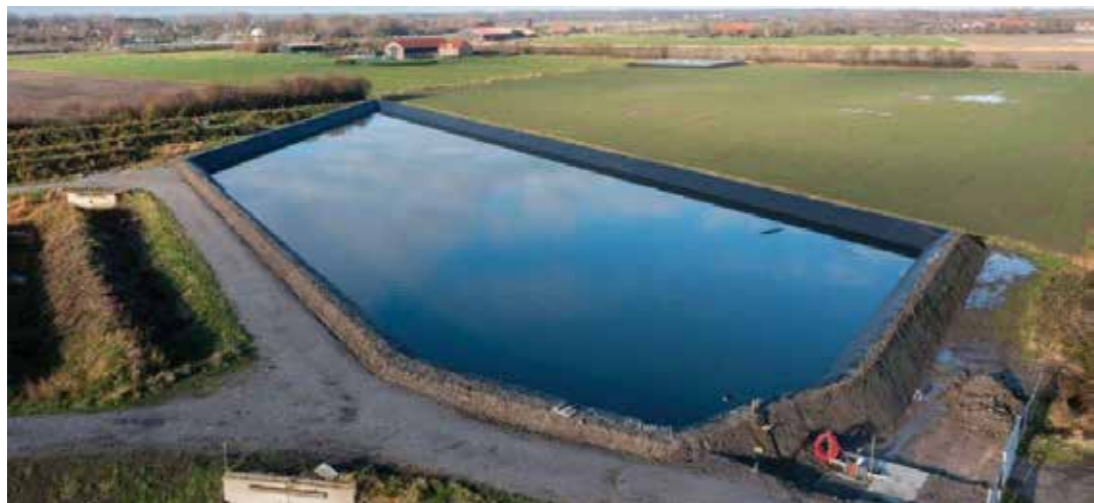
Fig. 33 Bazin de apă instalat de NPI Water Storage în Zeeland. 134
