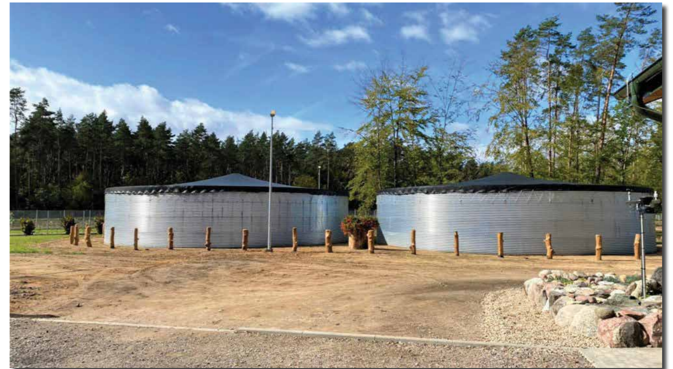
Fig. 34 Rezervoare de apă NPI din Jamy, Polonia. 135
